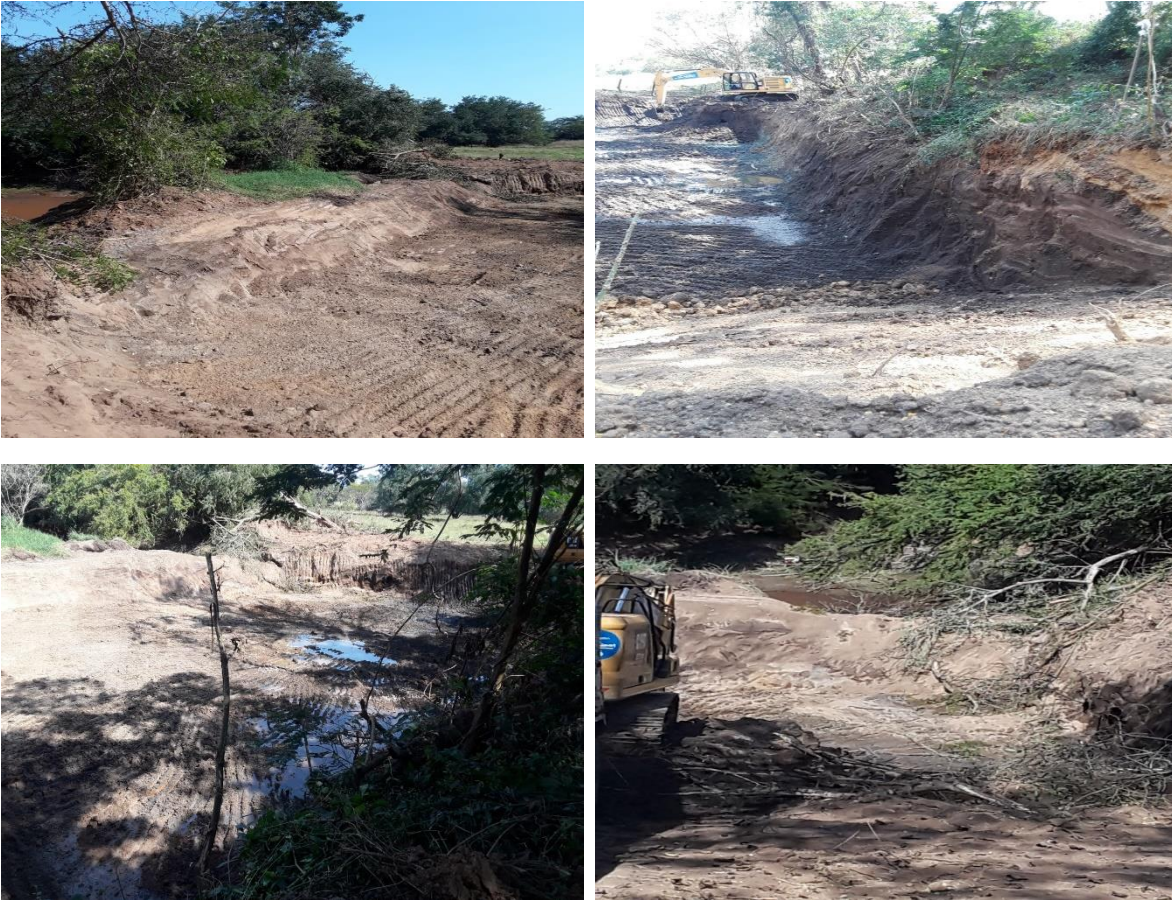
Imagen 13. Inicio de trabajo para el acondicionamiento del terreno.
