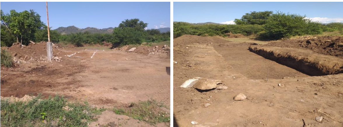
Imagen 5. Ejecución de obras para la Instalación del Sistemas Biodigestores en el rastro municipal La Huerta.
