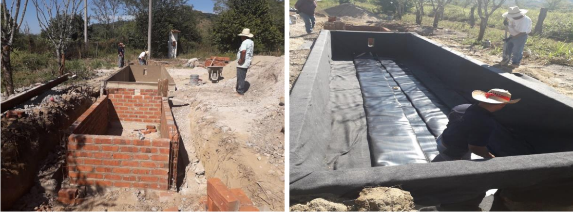
Imagen 3. Instalación del Sistemas Biodigestores en el rastro municipal de Cuautitlán de García Barragán.
