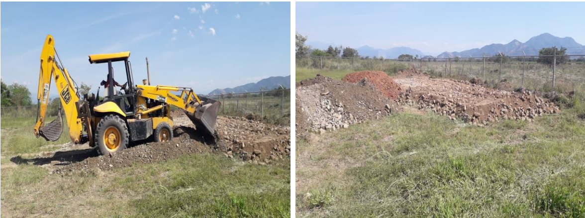
Imagen 4. Ejecución de obras para la Instalación del Sistemas Biodigestores en el rastro municipal Tomatlán
