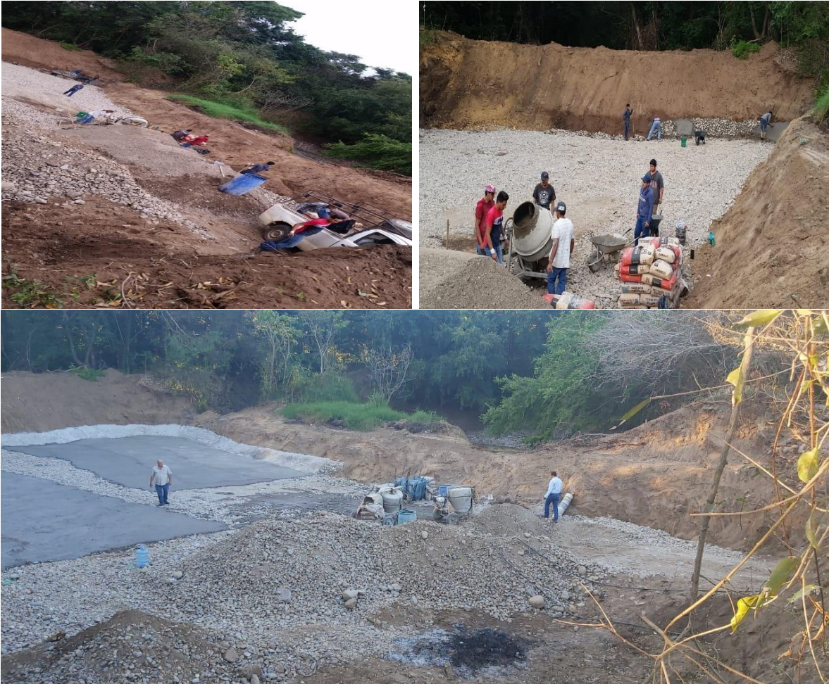
Imagen 14. Instalación de la capa impermeabilizante a través de obra de piedra ahogada.
