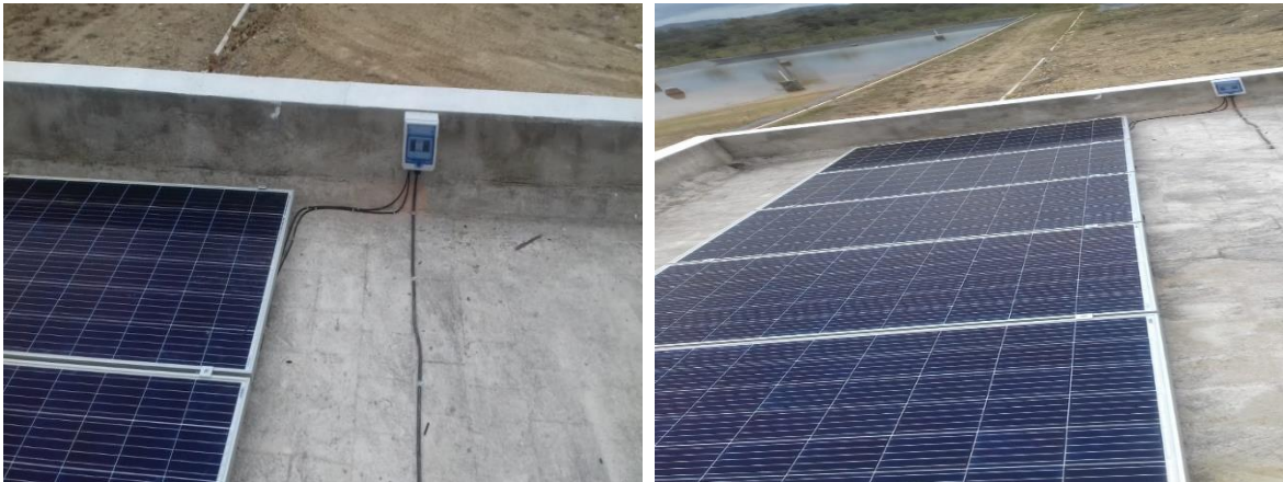
Imagen 10. Instalación del sistema eléctrico, panel solar en las instalaciones del relleno sanitario Intermunicipal de Villa Purificación.
