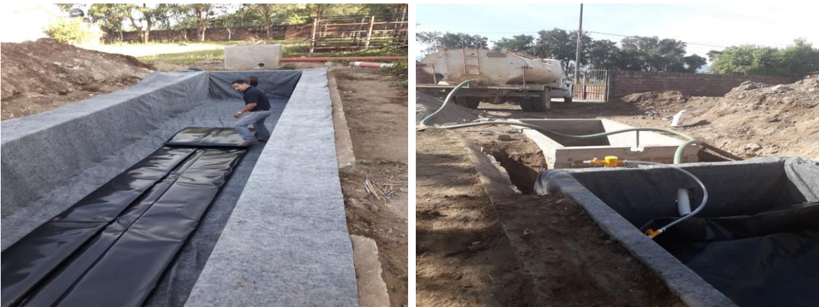
Imagen 2. Instalación del Sistemas Biodigestores en el rastro municipal de Villa Purificación.
