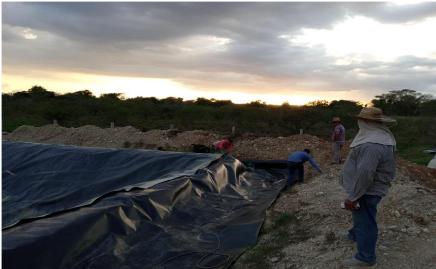
Actividades realizadas para la reparación de la Laguna de Lixiviados
