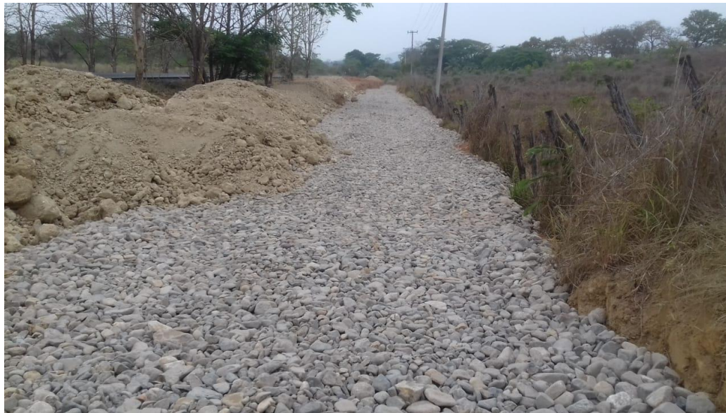
Actividades realizadas para la construcción de dren con Material Filtro
