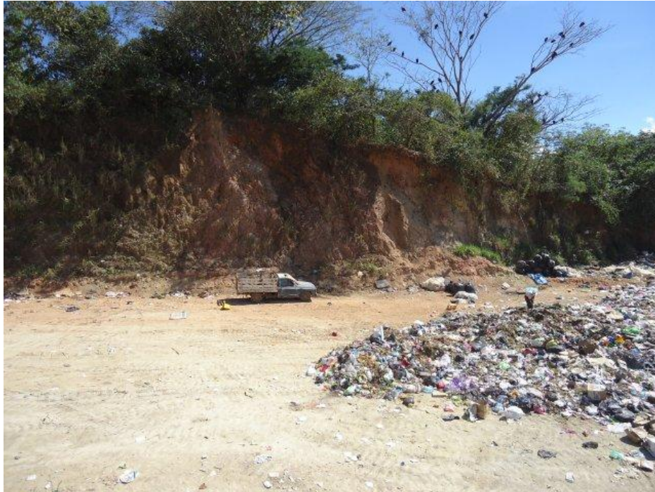
Cuando se lleva a cabo la cobertura, se utiliza material obtenido del mismo lugar donde se encuentra el sitio de disposición final.
