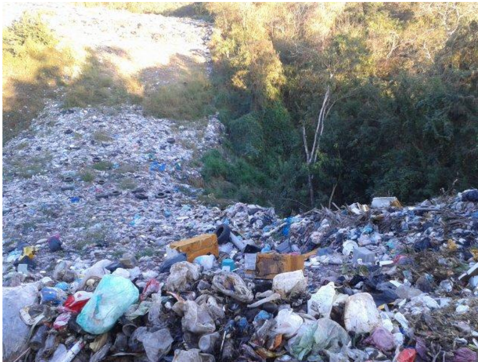
Talud de residuos sin cobertura en medio de la cuenca.
