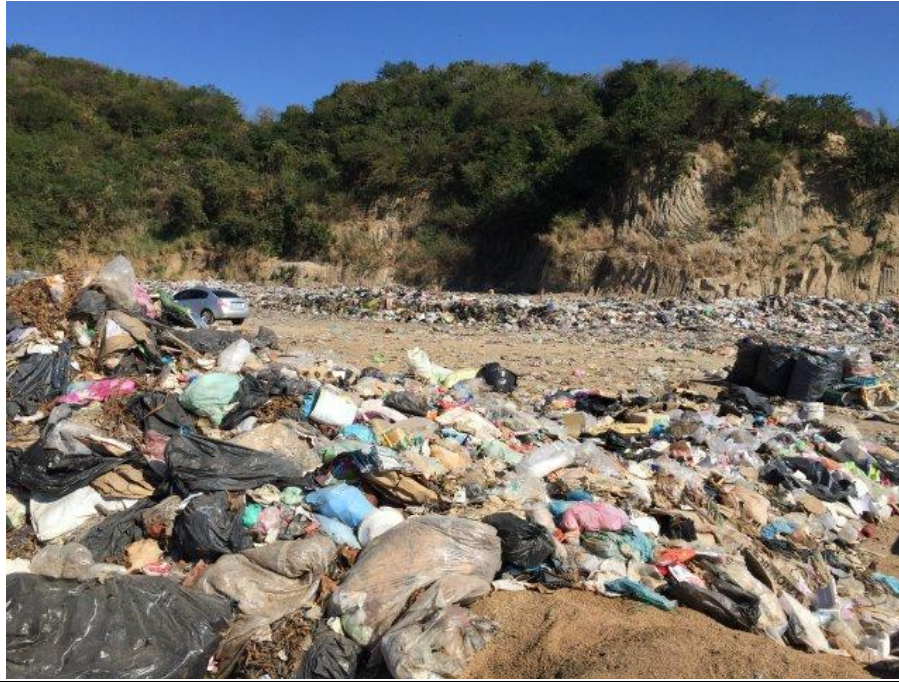
Se pueden observar los residuos dispersos en la parte superior de la celda y sin cobertura reciente.
