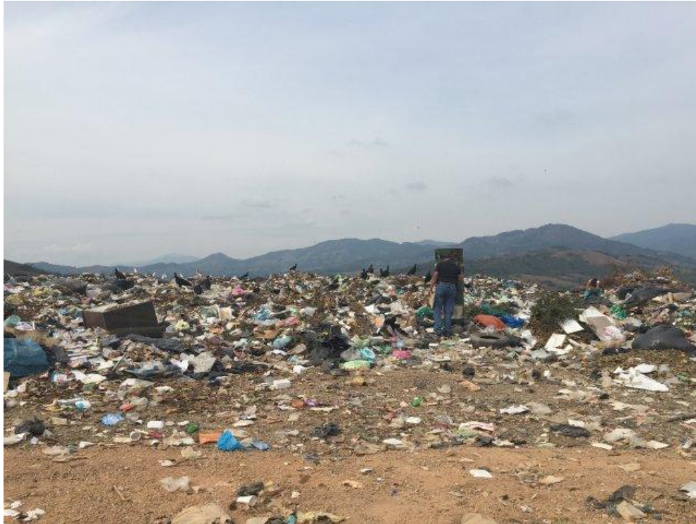
Residuos sin cobertura en la parte superior del relleno sanitario.
