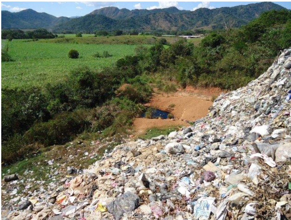
Vista de la fosa de lixiviados con que cuenta el sitio de disposición final.
