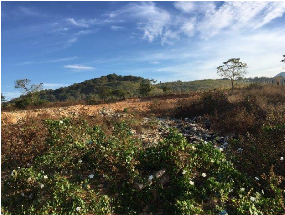
Talud de residuos sin cobertura, en la colindancia con la granja vecina.
