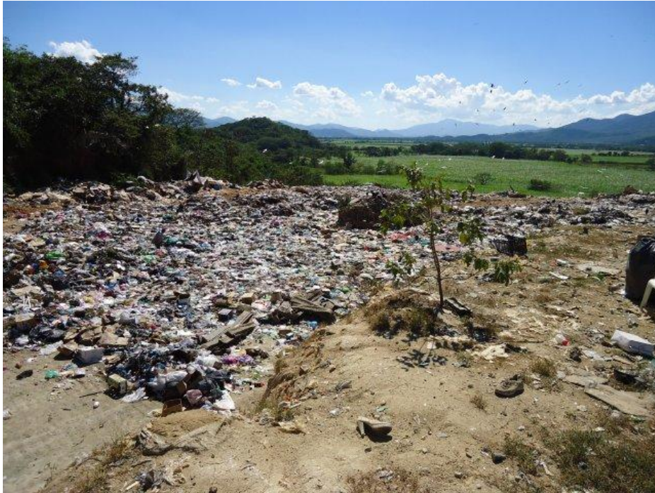
Se observa la falta de cobertura en los residuos de reciente vertido.
