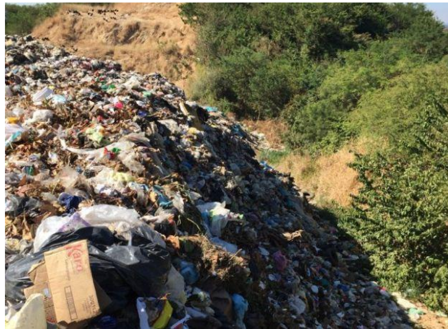
Taludes sin cobertura. Se requiere el desvío de aguas pluviales.
