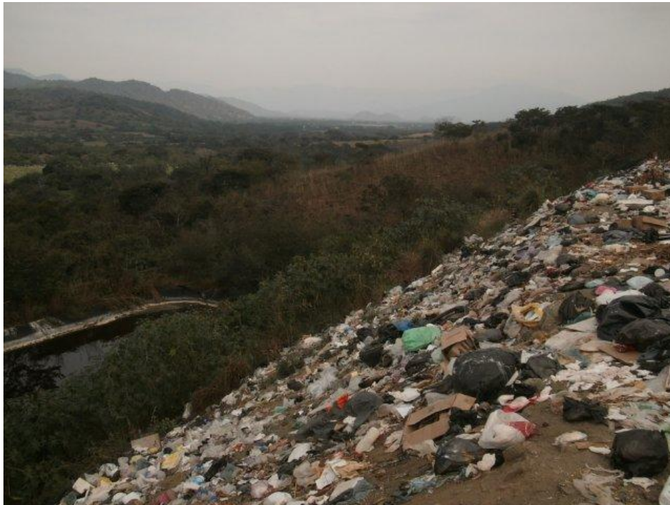
Residuos sin cobertura en el talud colindante con la fosa de lixiviados.
