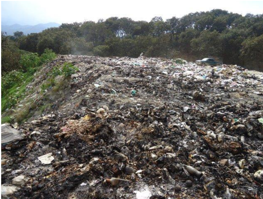
Residuos sin cobertura en plataforma y talud, con evidencia de quema.
