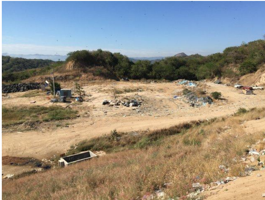
Se puede observar el área para la disposición final de las llantas y la fosa de lixiviados
