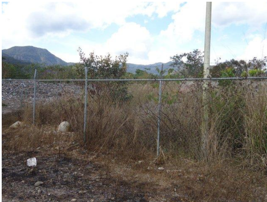
El basurero colinda con las instalaciones de la planta de tratamiento de aguas residuales de Cuzalapa, la cual no funciona desde que fue instalada.
