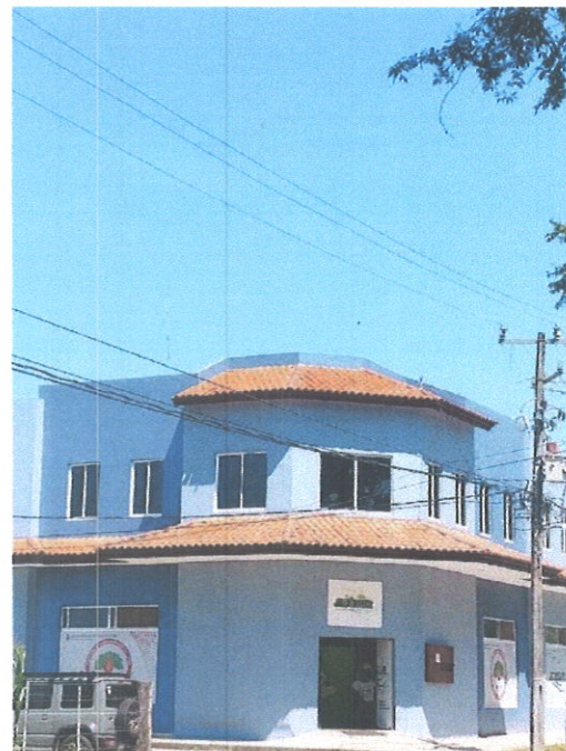
Ilustración 6 y 7: reinstalación de radio base.
