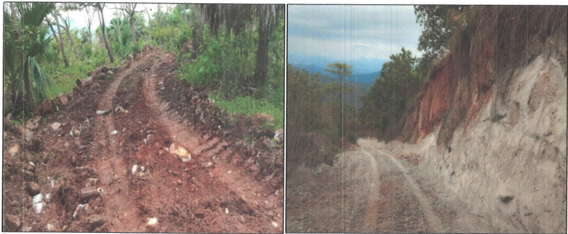
Imagen de trabajos realizados
